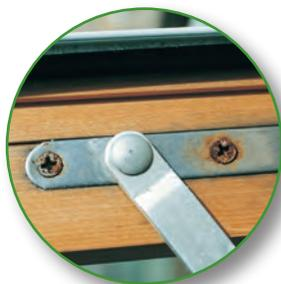
**Des test indépendants ont démontré que la rouille s'est répandue rapidement sur 10 % de la surface et qu'elle ressortait des orifices des vis lorsque des matériaux de nature différente étaient utilisés.**
